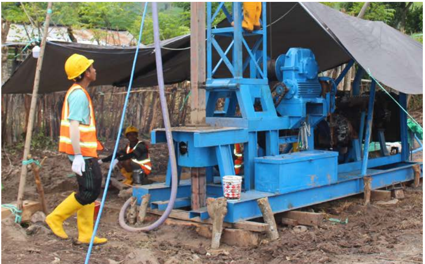
Proses pengeboran sumur bor dalam untuk memenuhi kebutuhan air bersih warga Marada, Kamis (27/1/2022)
