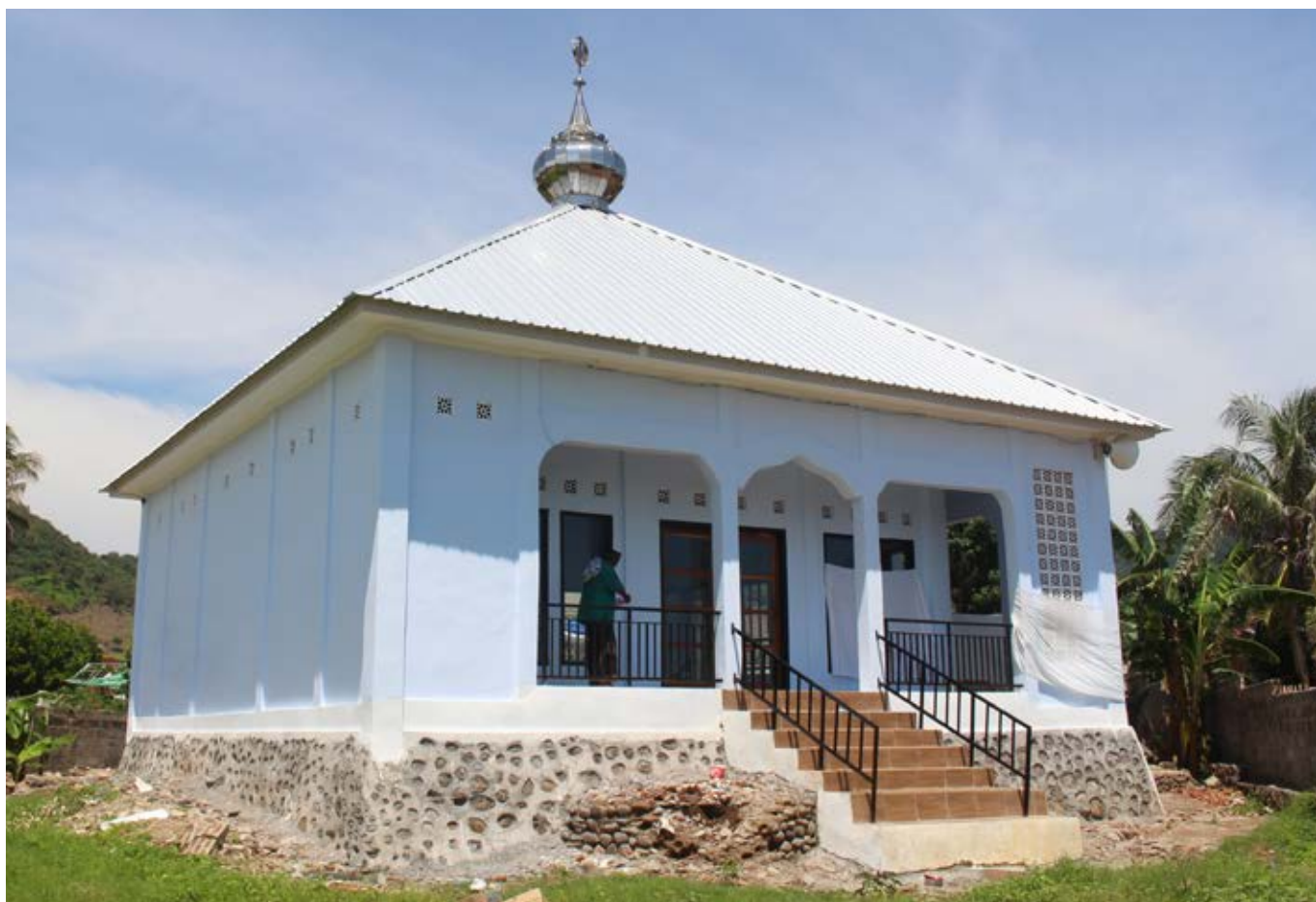
Tampak depan Masjid Al Abrar setelah selesai dibangun ulang.
