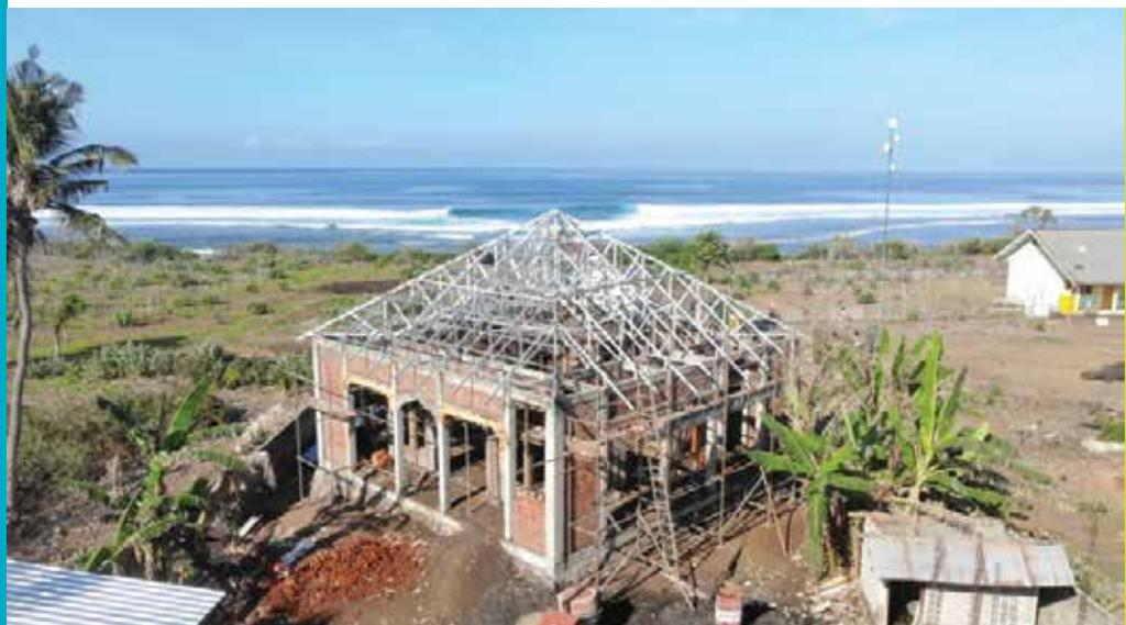
Foto Pekerjaan Pemasangan bata dan pemasangan rangka atap
