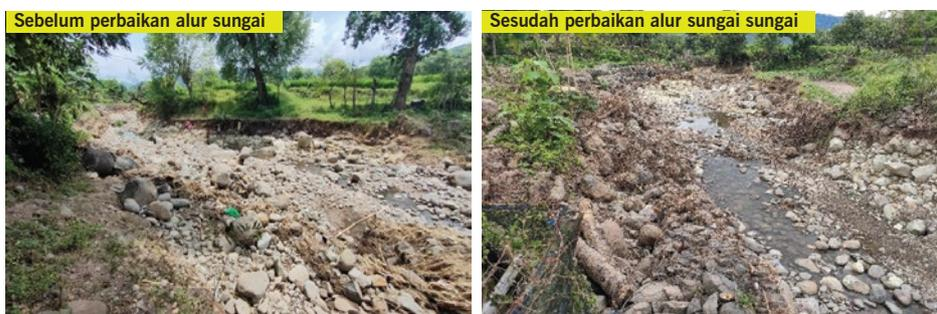
Pembuatan Revetment sungai berupa tanggul batu sepanjang 75 meter, lebar 3 meter dan tinggi 2,5 m di daerah meander sungai yang mengarah ke hilir yang terlihat pada gambar 9 :
