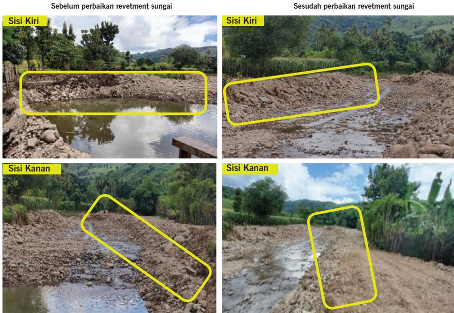
Sepanjang 80,14 meter, tinggi 2 m Perlu dilakukan perbaikan revetment tanggul batu agar menjaga terjadi longsor atau gerusan untuk mencegah pendangkalan sungai dan mengembalikan fungsi revetment sebagaimana mestinya, yang terlihat pada gambar 7.
